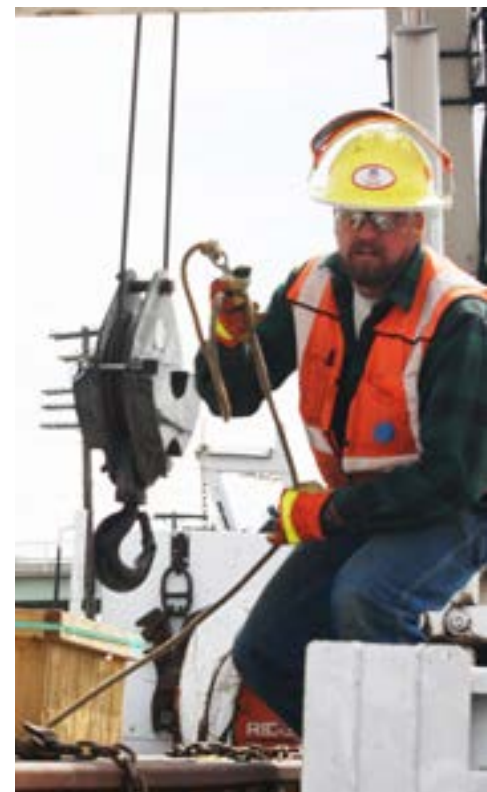
Sectionman Dan Uhlenkott unloads rail.
